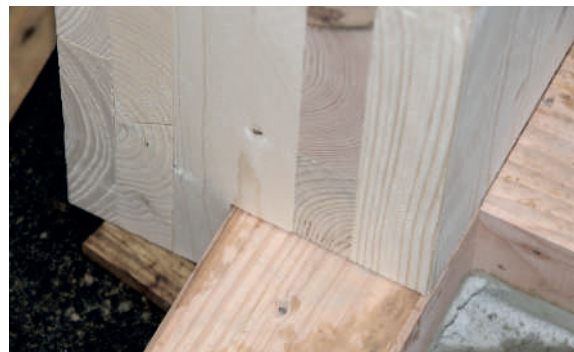
Fertig abgebundene Douglasien-Schwellen.
