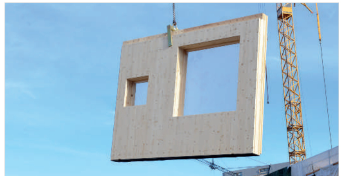
Eine fertig abgebundene 21,5 cm Wand am Kranhaken.
