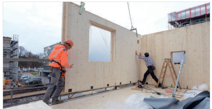
Massive Wände müssen millimetergenau eingebaut werden.
