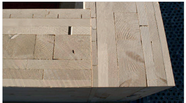
Eine Eckverbindung mittels Ausklinkung.
