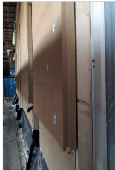
Direkt auf die NUR-HOLZ Wand aufgebrachte Holzweichfaser-Dämmung.
