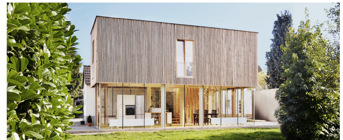
Aufstockung; Holzhüter Architektur, Aachen
