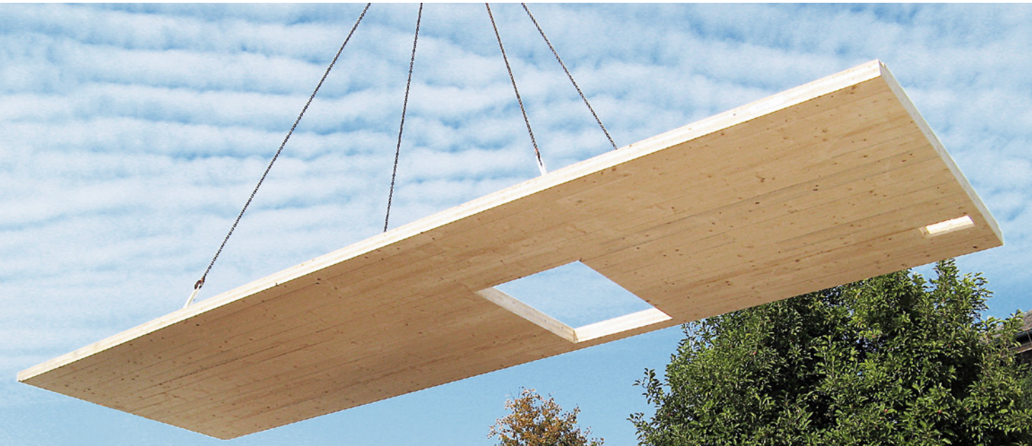
Montage Wohnhaus, Kühnbach
