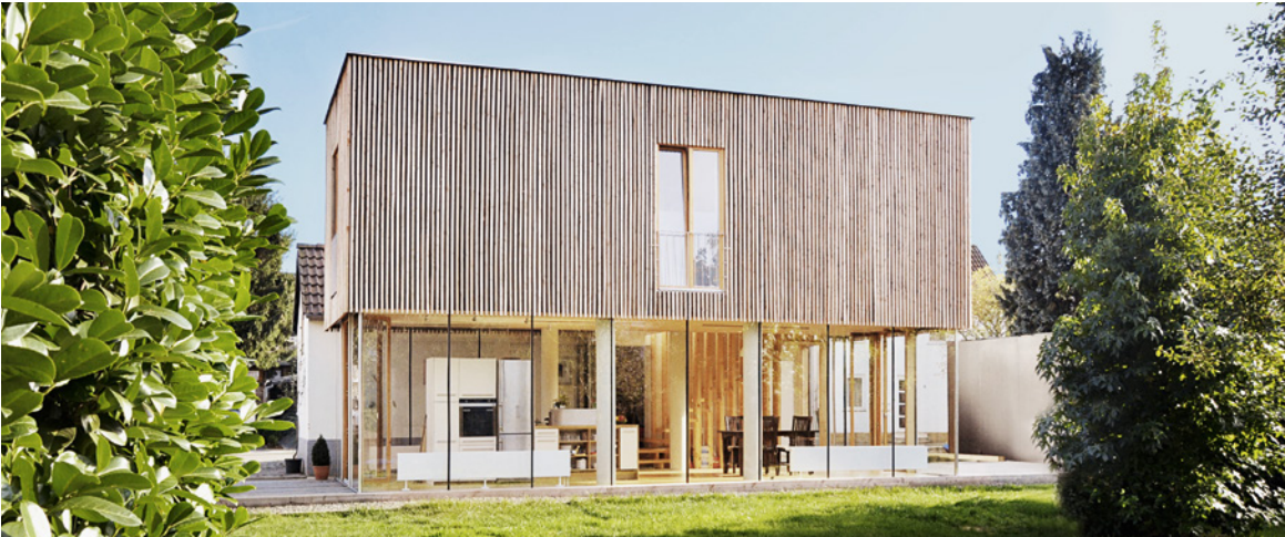
Aufstockung; Holzhüter Architektur, Aachen
